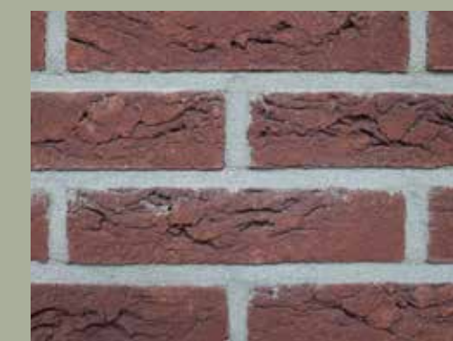
Metselwerk kavel 9, 10, 29 en 30
